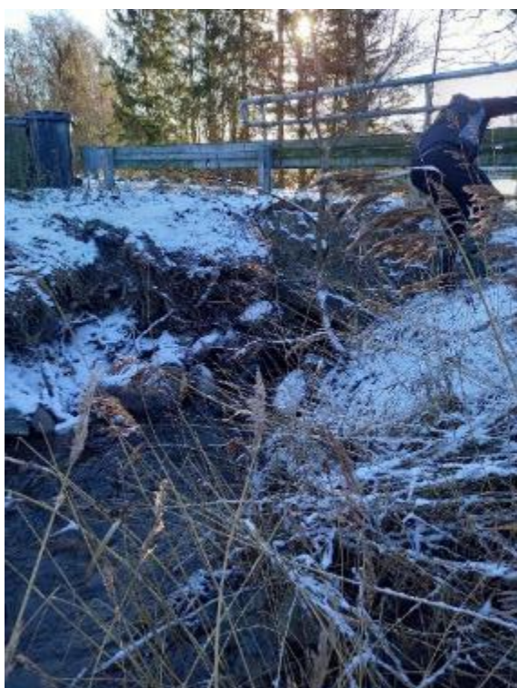
Foto 17. Underføringen under Øster Egeborgsvej st. 1930-1934
